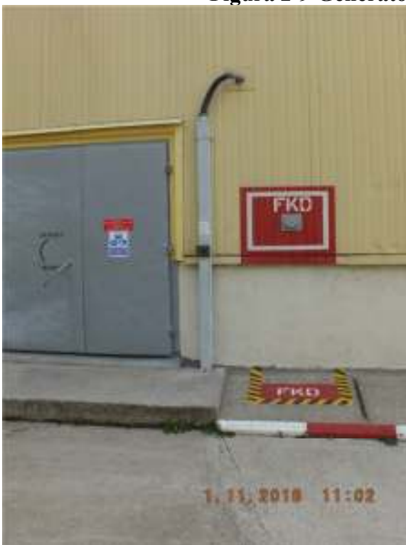
Figura 2-10 Puncte de conexiune electrice a generatoarelor electrice Diesel mobile
