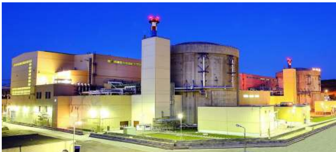
Figura 1-7 Vedere de ansamblu a Unitatii 2 de la CNE Cernavoda
