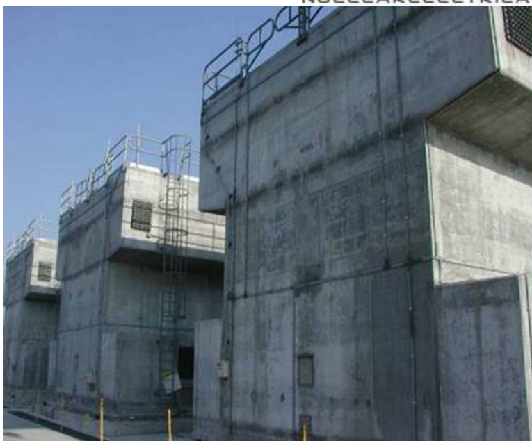
Figura 1-11 Module din Depozitul Intermediar de Combustibil Ars
