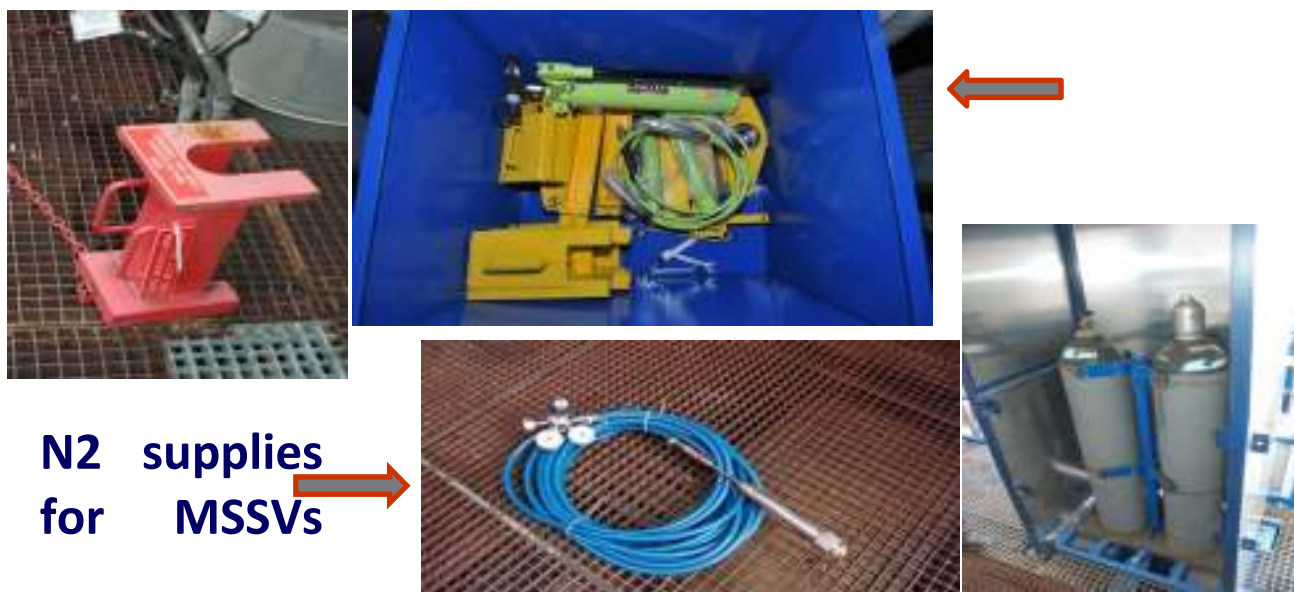
Figura 2-8 Dispozitive pentru deschiderea manuala si blocarea supapelor de protectie la suprapresiune care descarca in atmosfera aburul de la generatoarele de abur
