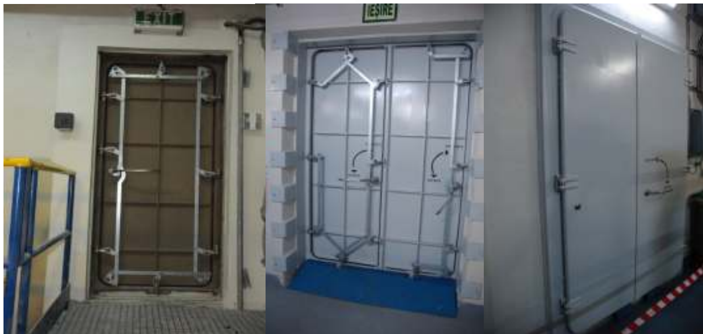
Figura 2-7 Usi rezistente la inundatii
