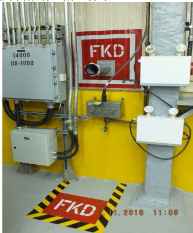
Figura 2-10 Puncte de conexiune electrice a generatoarelor electrice Diesel mobile
