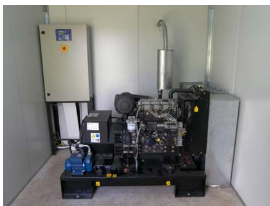
Fig. 8.3 Generator DIESEL pentru alimentarea cu energie electrică a Centrului de Răspuns la Urgențe al CNCAN, în situații de întrerupere a alimentării cu energie electrică de la rețeaua națională
