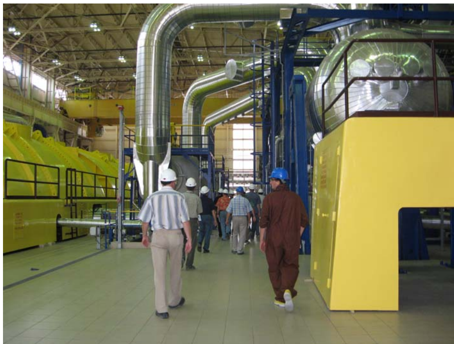
Fig. 2.14. Inspecție CNCAN la CNE Cernavodă U2 privind activități de punere în funcțiune
