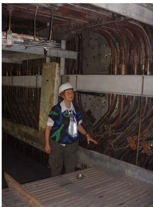
Fig. 2.7. Imagine a reactorului nuclear CNE Cernavodă Unitatea 2 în faza lucrărilor de construcții – montaj, inspecție CNCAN, feederi
