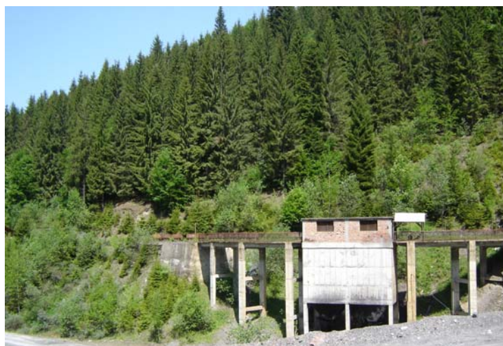
Fig. 6.14 Controlul activității de exploatare a minereului de uraniu – descărcarea, din vagoaneți în silozuri colectoare a minereului de uraniu rezultat de la exploatarea în subteran
