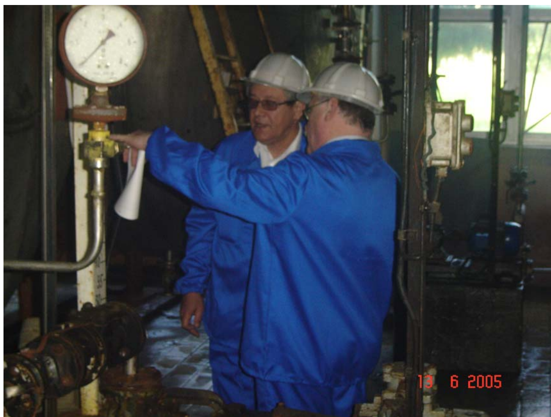
Fig. 5.4 Aspecte din timpul inspectiei AIEA si CNCAN la CNU, Sucursala Feldioara
