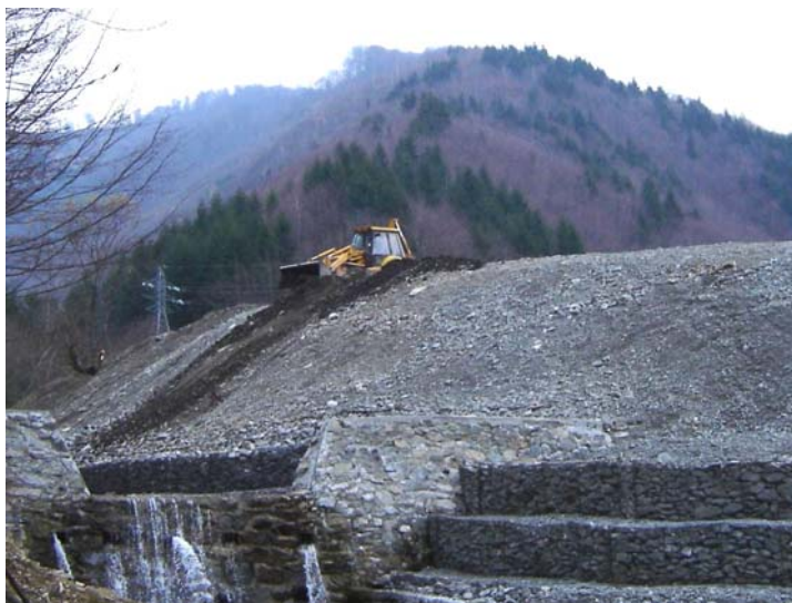
Fig. 6.11 Stabilizarea haldei de roci sterile în cadrul activității de dezafectare a unei mine de uraniu
