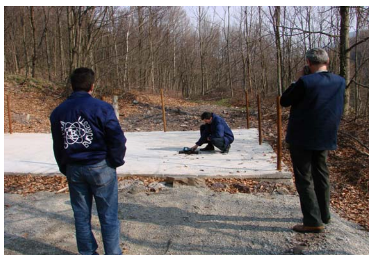
Fig. 6.16 Controlul activității de dezafectare a instalațiilor miniere de exploatare a minereului de uraniu – închiderea unui puț rambleeat cu placă de beton armat prevăzută cu fereastră de control pentru completarea rambleerii, după tasare
