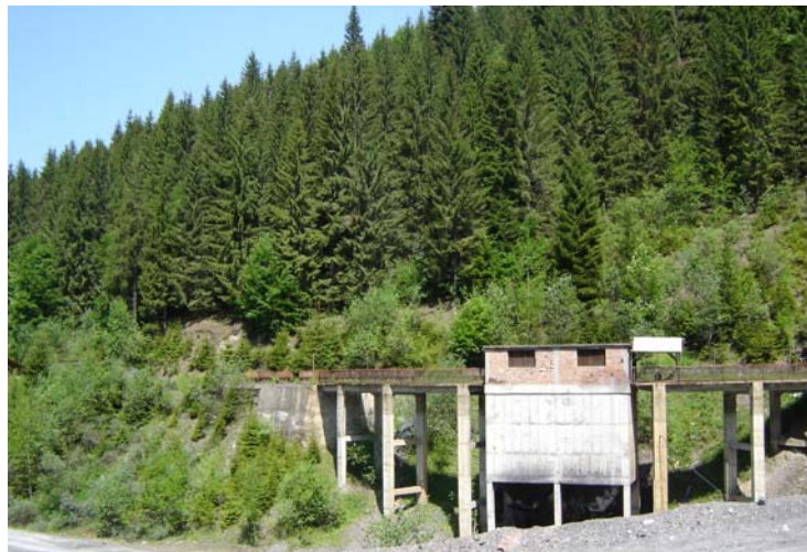
Fig. 6.14 Controlul activității de exploatare a minereului de uraniu – descărcarea, din vagoneți în silozuri colectoare a minereului de uraniu rezultat de la exploatarea în subteran
