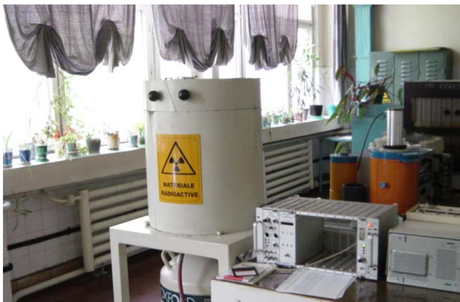
Fig. 7.30 Aspecte de la instalațiile controlate în unități radiologice industriale și medicale
