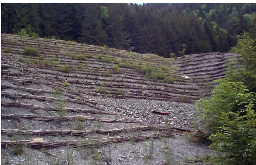
Fig. 6.13 Halda de roci sterile stabilizată în cadrul activității de dezafectare a unei mine de uraniu
