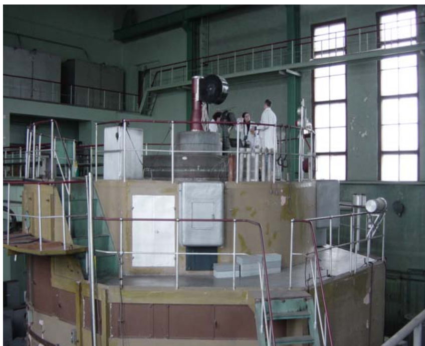
Fig. 1.28 Inspecție CNCAN la reactorul VVR-S
