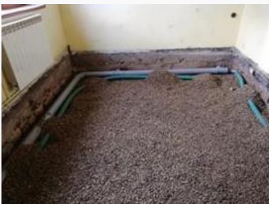
Figura 15 - Depresurizarea solului sub membrană aplicată la clădiri din România
