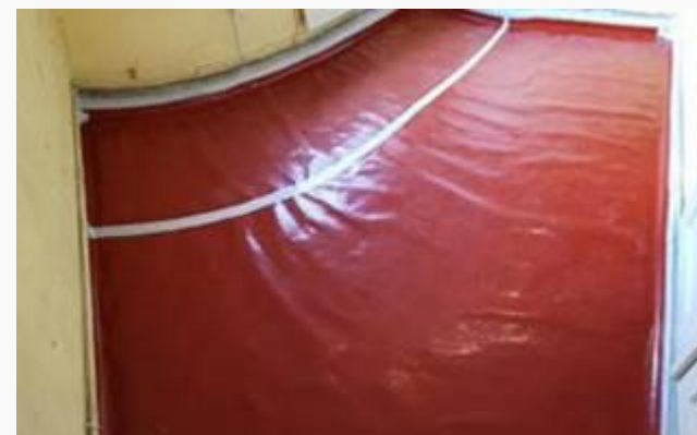
Figura 15 - Depresurizarea solului sub membrană aplicată la clădiri din România
