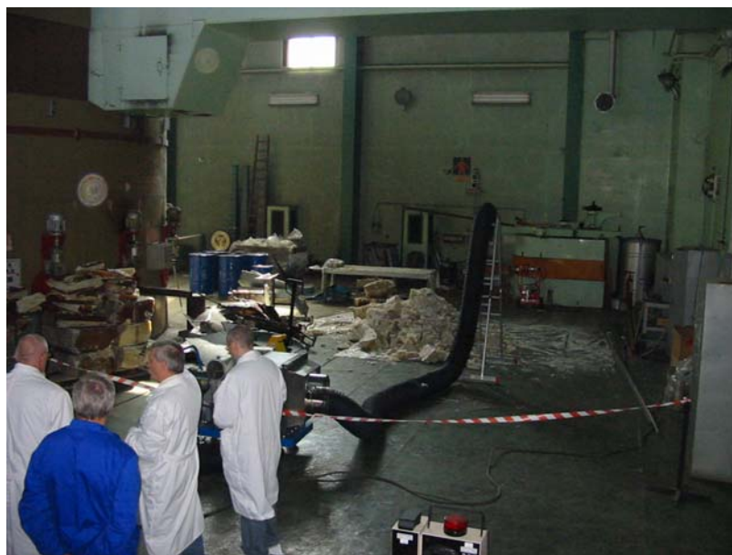
Fig. 2.3 Aspecte din Hala Reactorului Nuclear VVR-S de la IFIN-HH, în faza de conservare – curățare în vederea dezafectării, în timpul inspecției CNCAN din luna martie 2006.
